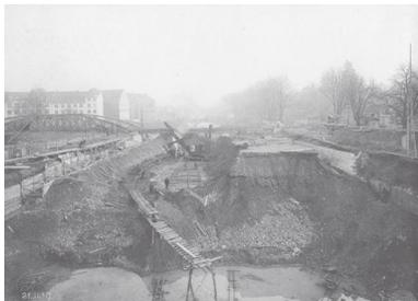
Die Tieflegung der Seebahnlinie hatte die Verlegung der Sihl zur Folge. Das Bild gibt Einblick in die umfangreichen Erdverschiebungen. Das Aushubmaterial wurde für den Bau der Quaianlagen im Mythenquai verwendet. (Foto BAZ 1919)
